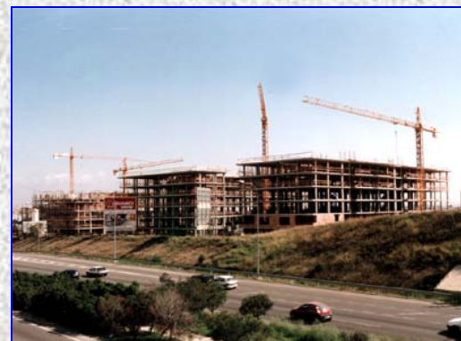
Edificio de Viviendas (Mallorca)
