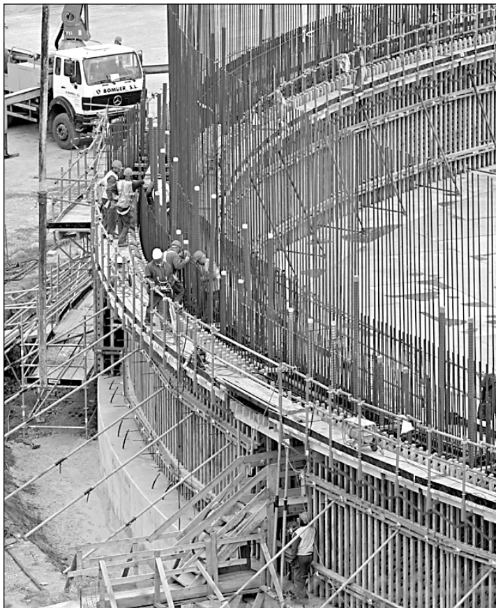
En la imagen se aprecia la altura alcanzada por el primero de los anillos
