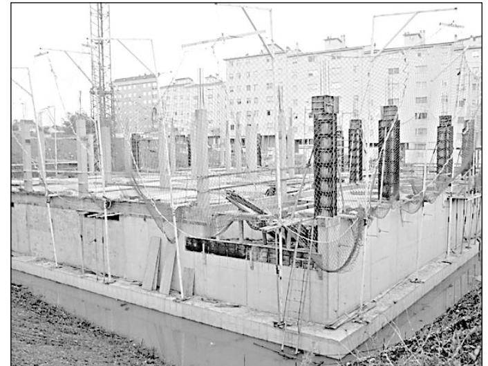
Las obras que se ejecutan en Tejeras avanzan a buen ritmo / J. Meis
