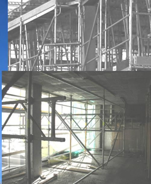
Detalle de la estructura de apuntalamiento interior, para soporte de andamio de fachada que no puede ser apoyado en la vía pública.
